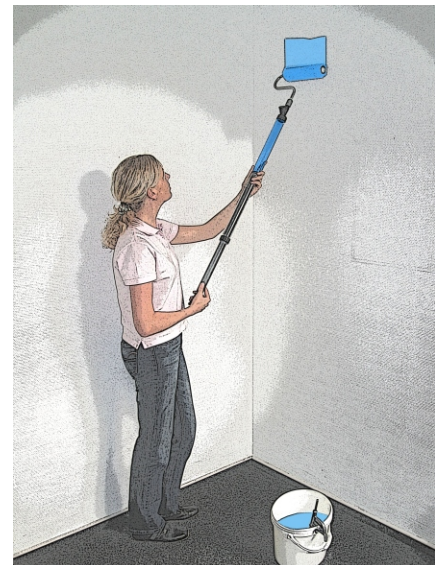
Griff des Paint-Stick XXL rollers zusammenschieben, so dass die Farbwalze mit Farbe getränkt wird.
