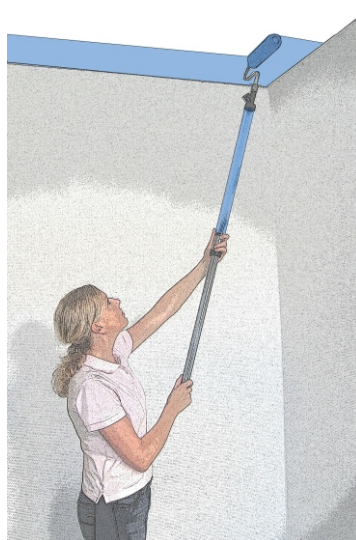
Auch die Decke lässt sich einfach, schnell und problemlose bearbeiten.
